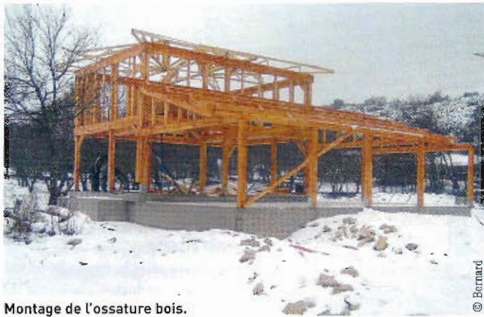
Montage de l'ossature bois.
