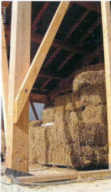
Montage de l'ossature bois.
